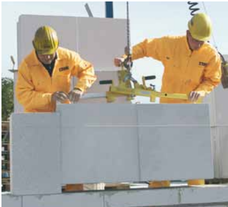
Minikran med dubbelgripare som kan placera ut 0,78 m 2 åt gången
