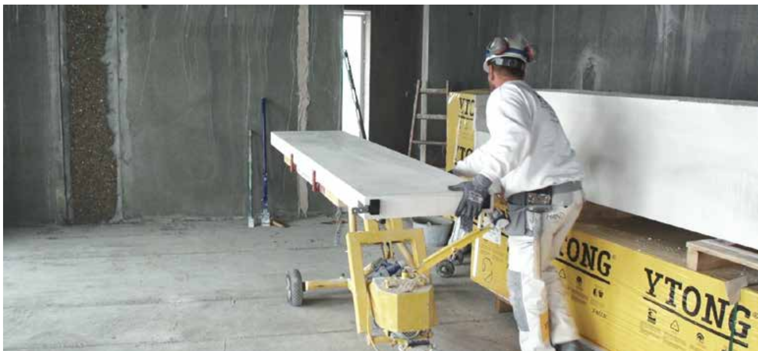
Med den speciellt utvecklade el-drivna Ytong Montagevagn kan väggen monteras av en man.
