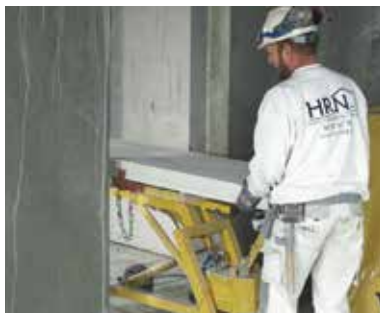
Ytong Montagevagn med Väggelement kan komma igenom alla dörröppningar.
