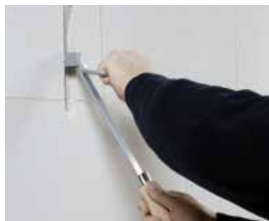
El-installationer spåras in i elementen efter montaget. Det ger stor flexibilitet både i projekteringskedet och i utförandet.
