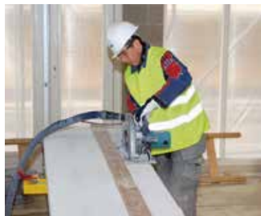
Ytong Montagevagn fungerar som ergonomiskt arbetsbord vid kapning av elementen.
