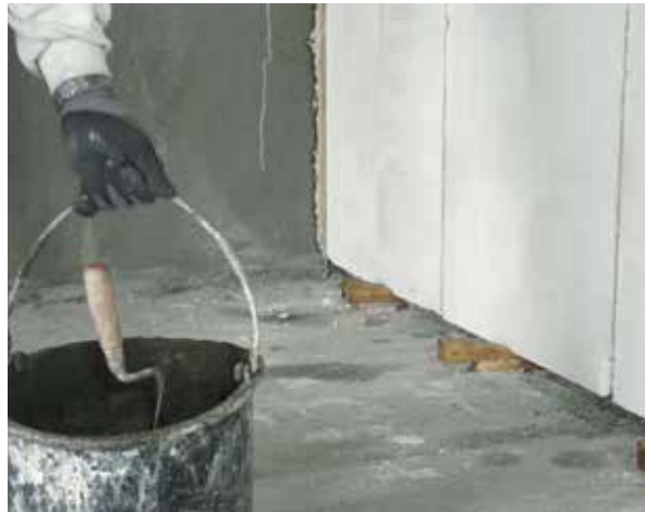
När tunnfogslimmet har härdat, undergjuts väggen.
