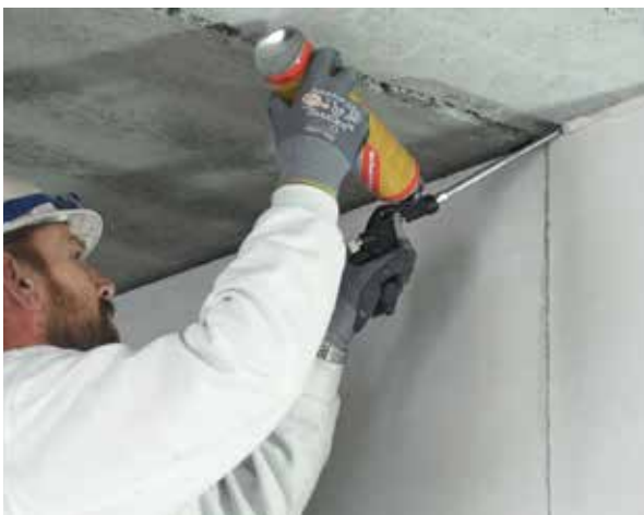
Fogskum eller drevning appliceras mot taket.
