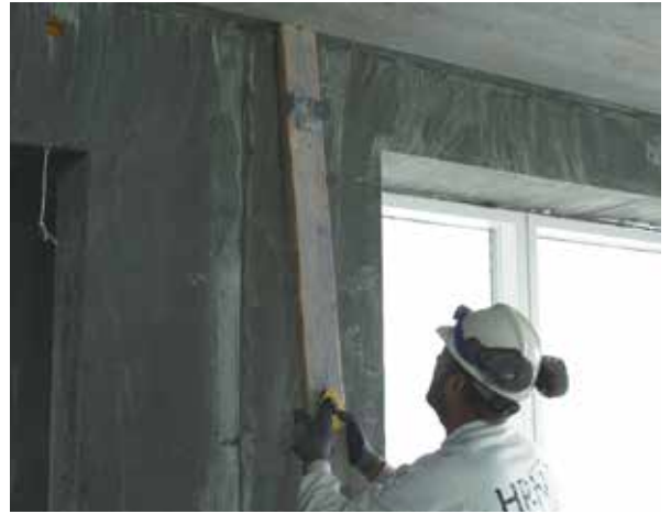
Väggens lodräta placering märks ut på anslutande vägg.
