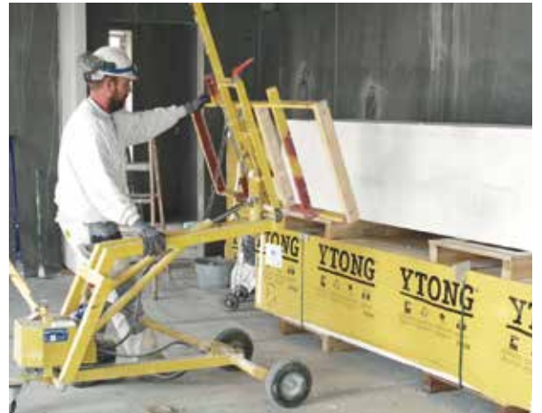
Ett väggelement lyfts från pallen med montagevagnen.
