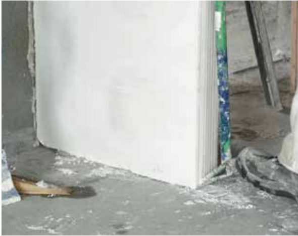
Elementen trycks på plats med specialverktyget eller med en kofot.
