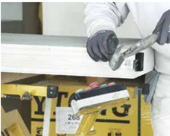
Eventuell tillkapning utförs med cirkelsåg. Avståndsklossar och fjäderbeslag monteras.
