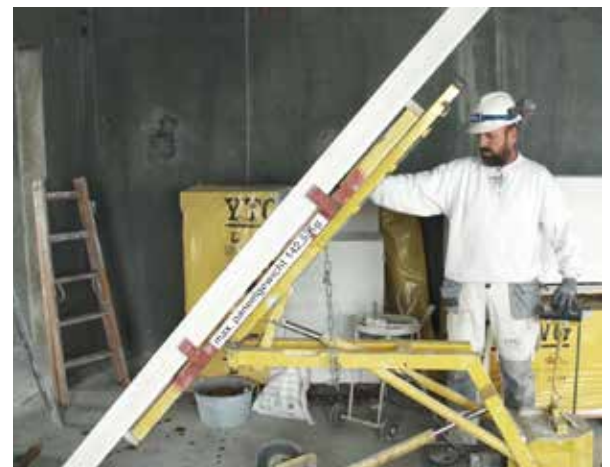
Elementen reses med hjälp av montagevagnen.
