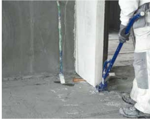
Elementet lyfts upp mot taket med lyftverktyget, som låses, medan man applicerar kilar under elementet.
