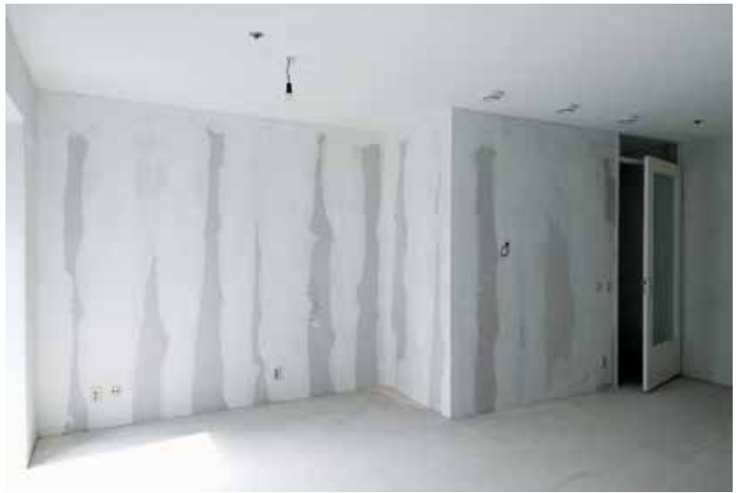
Ytong väggelement är tillverkade av kalk, sand och vatten och lite cement och utvecklas i Xellas Research och utvecklingsavdelningen i syfte att maximalt miljöhänsyn.
