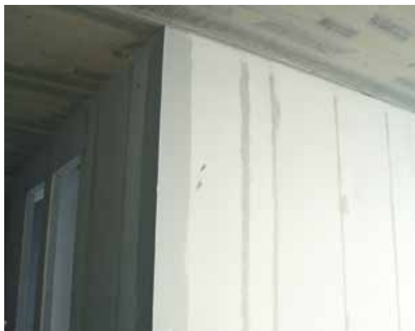
Utåtgående hörn förstärks med hörnprofil.
